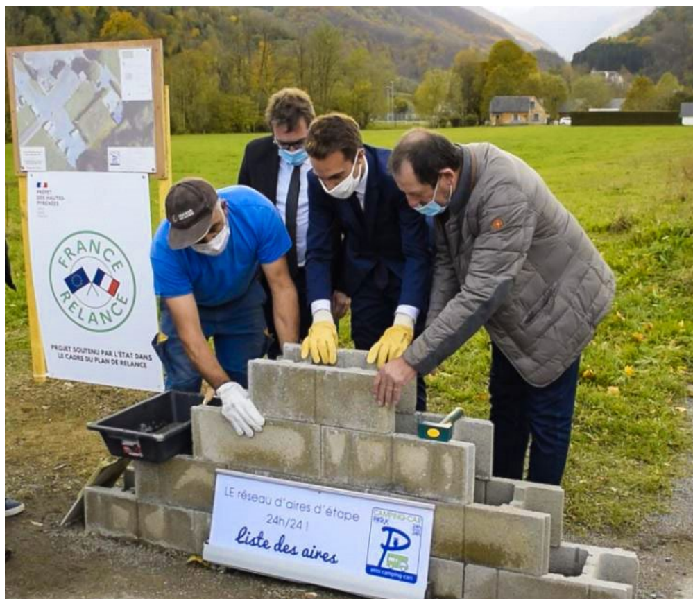
Arrens-Marsous, création et aménagement d'une aire de camping-car. Montant des travaux : 100 379 euros. Soutien de l'État dans le cadre de France Relance : 50 000 euros.
